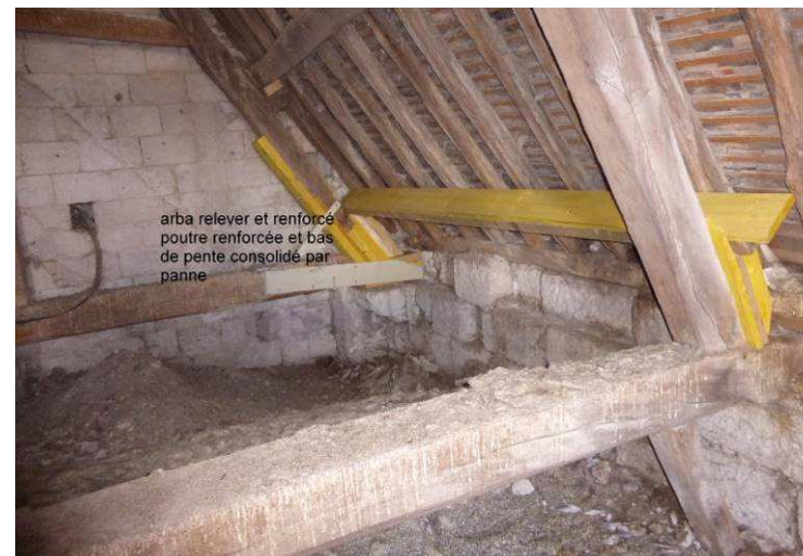
Figure 72 – Vue du pan occidental après renforcement de 2017 – Clichés transmis par l'architecte
