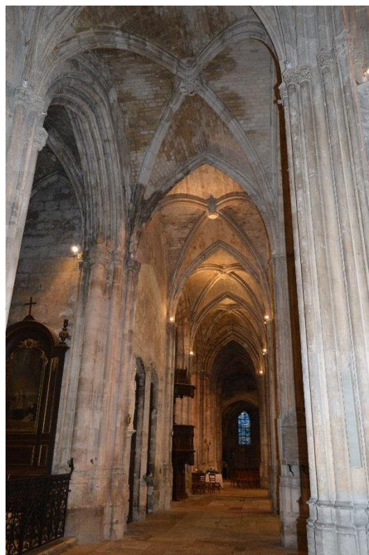
Vue du bas-côté nord
