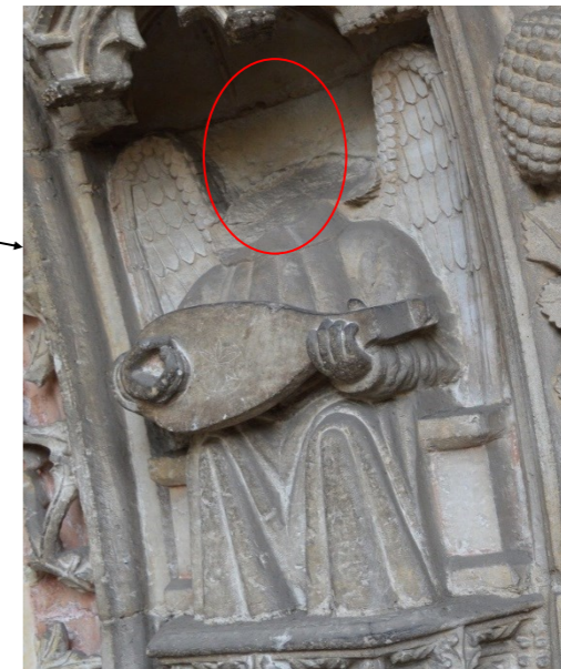
Lacune historique liée au vandalisme
