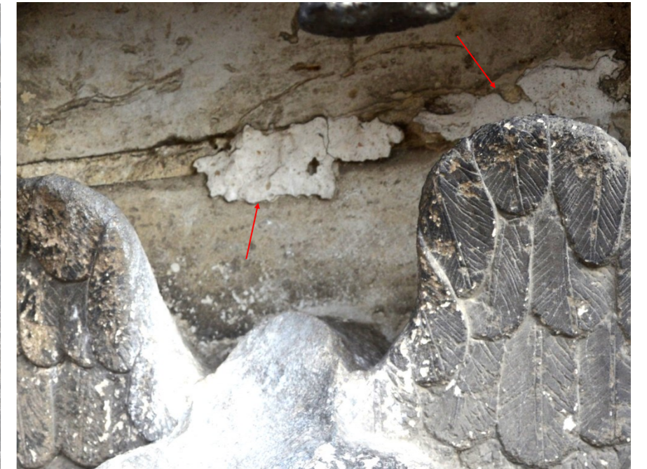
Joint de rebouchage au plâtre
