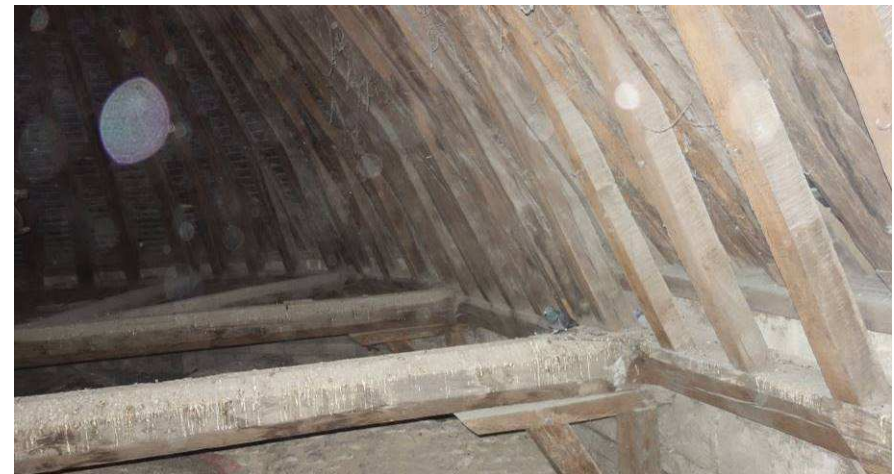
Figure 70 – Vue globale de la charpente du chœur
