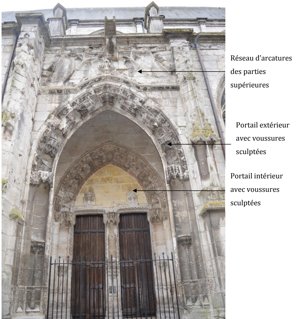
Vue générale du porche nord
