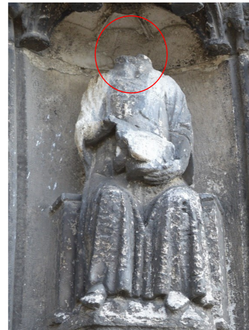
Lacune de la tête due au vandalisme
