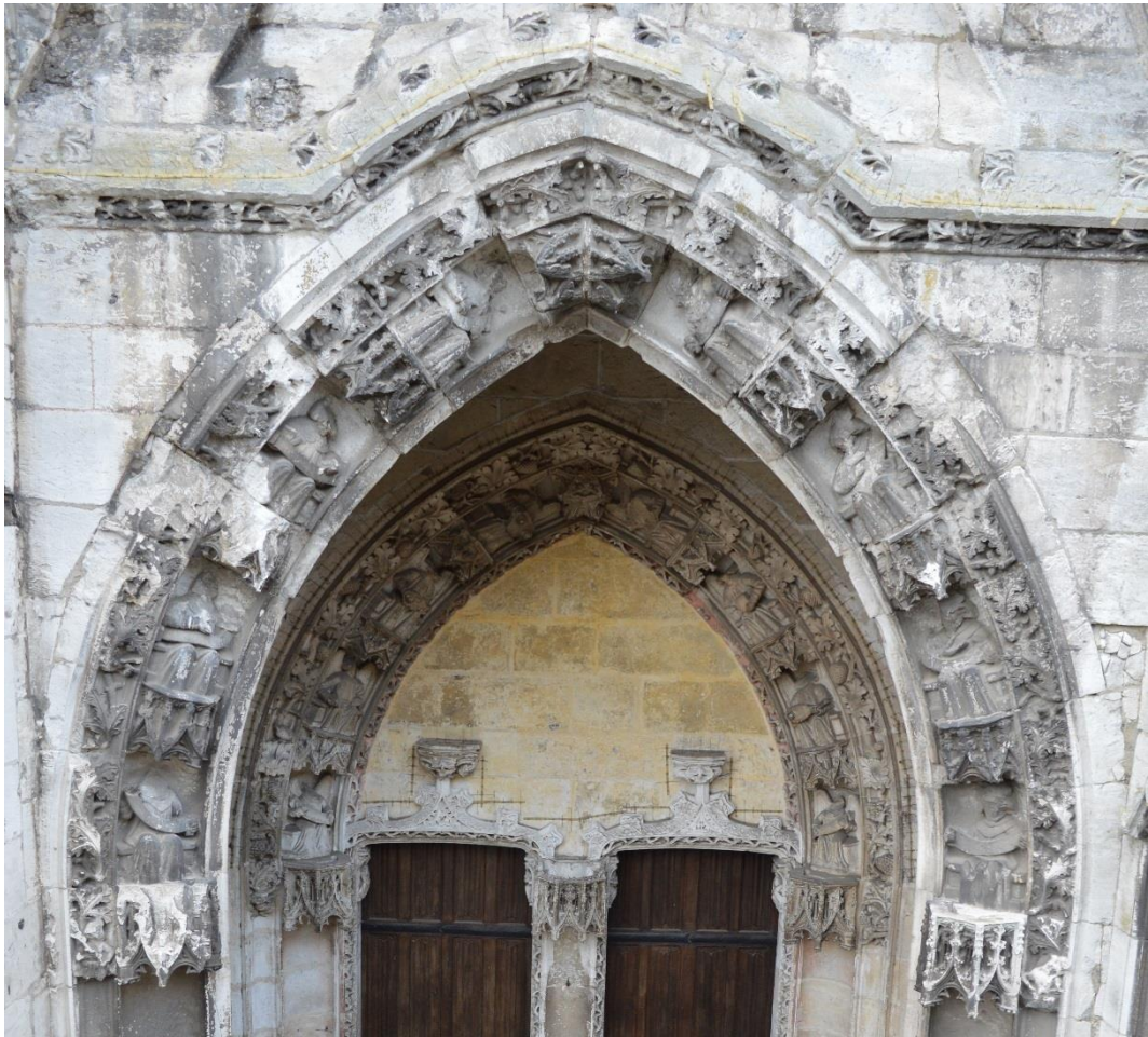
Vue des décors des voussures du portail extérieur nord
