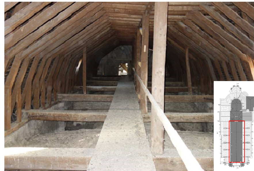
Figure 55 - Charpente de la nef, vue d'ensemble depuis l'Ouest.
