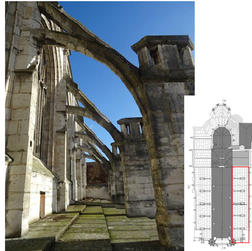
Figure 27 - Terrasse Sud, arcs-boutants 2 à 6. Au fond : toiture de la sacristie
