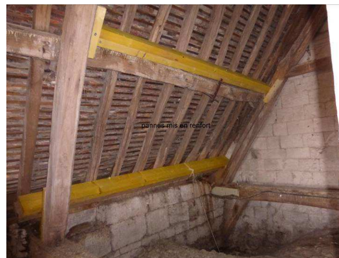
Figure 73 – Vue du pan oriental après renforcement de 2017 – Clichés transmis par l'architecte
