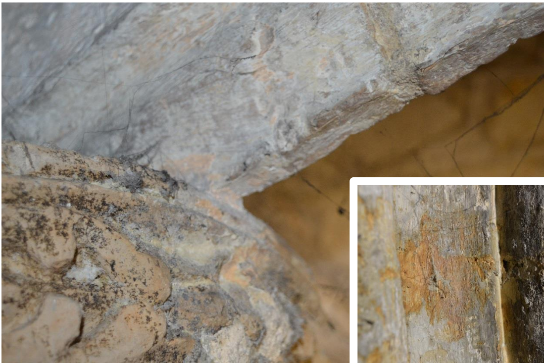
Vue rapprochée de vestiges de badigeon blanc recouvert d'un ocre jaune à orangé puis d'un jus brun à gris sur les nervures et la clé de voûte d'une travée du bas-côté nord
