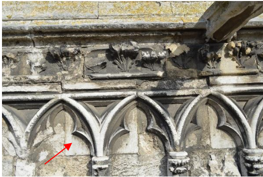
Pierres remplacées en partie haute
