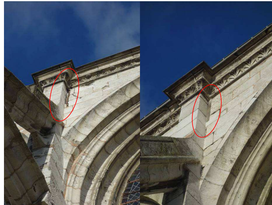
Figure 31 - Ancrages métalliques en tête d'arc-boutant. A gauche : arc-boutant 4 ; à droite : arc-boutant 6.
