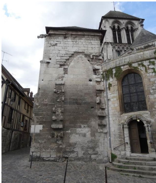
13. Façade orientale : sacristie, déambulatoire, tour de la croisée.
