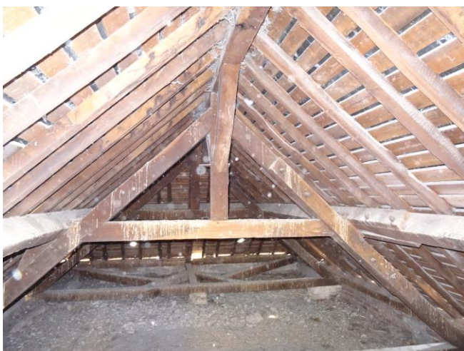
35. Comble de la sacristie.
