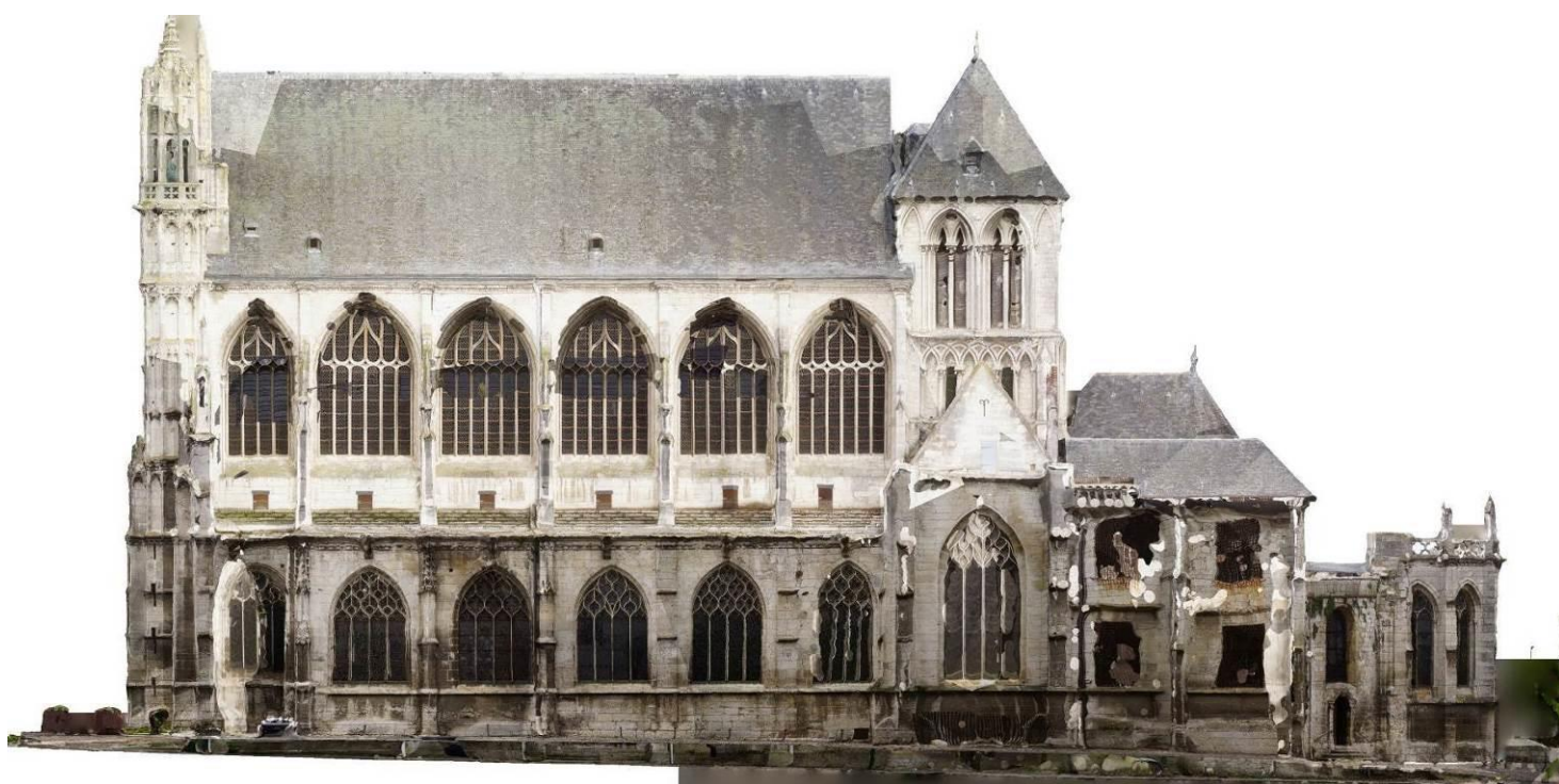
52. Façade du midi (cliché de Latitudes, géomètres experts, 2017)
