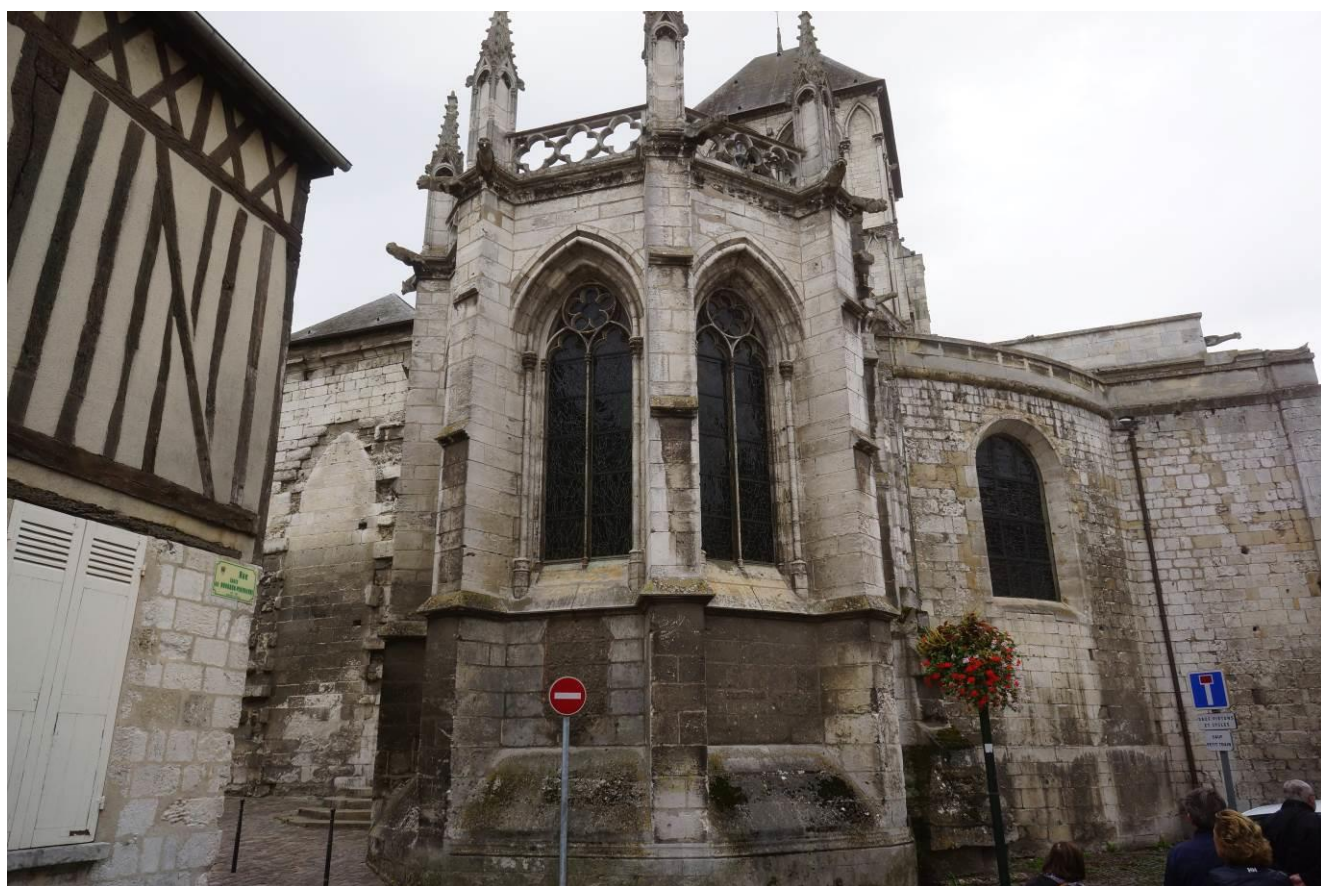
11. Façade orientale : chapelle axiale, déambulatoire, sacristie, tour de croisée.
