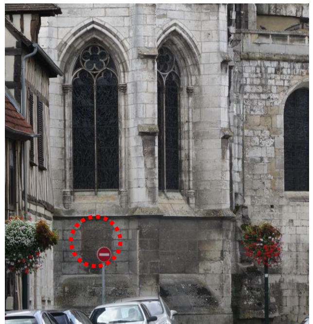
17. Niche bouchée aujourd'hui.
