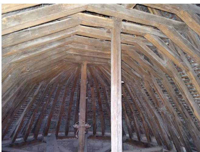
31. Comble du chœur.
