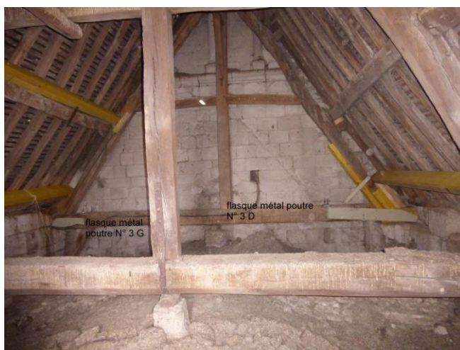
34. Comble du transept Sud, (cliché des Ateliers Aubert-Labansat).
