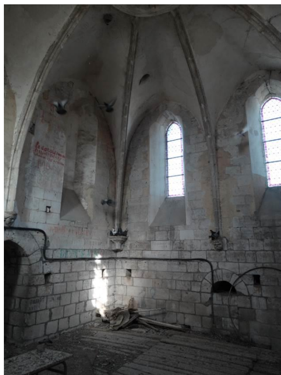
29. Chapelle haute (au-dessus de la croisée).
