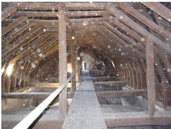
30. Comble de la nef.
