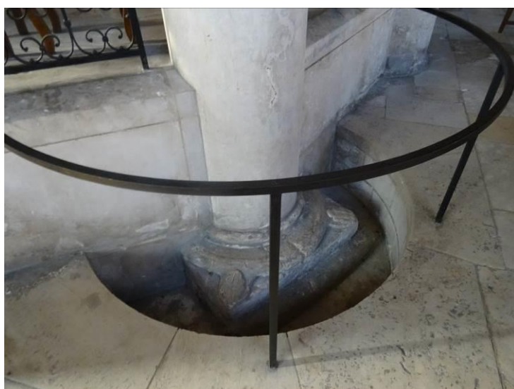
34. Etat de la pile en 2017. Les traces de reprise restent visibles. On remarque le sol a été remonté de 50 cm suite à la crue de Seine en 1658.
