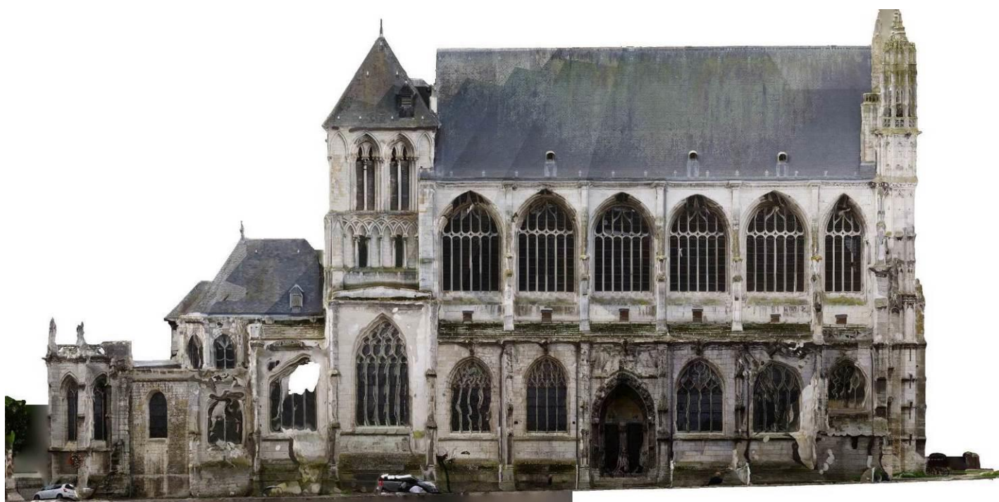
25. Façade septentrionale (cliché de Latitudes, géomètres experts, 2017)
