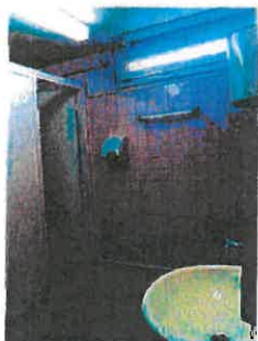
Sanitaire en sous-sol
