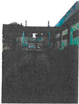
Portail automatique permettant d'accéder au parking
